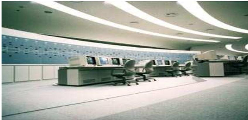
中央指令室主要任務為監控東海道與山陽新幹線全線全天候運轉狀況，同時控制高速鐵路系統，包括列車、號誌、電力、通訊、道旁等系統。監視行車安全之各種因素(包括地震、雨量、洪水、風速、落石、山崩、道路車輛侵入等)，充分提供行控中心所需資訊並降低人力需求，提昇工作效能與服務品質，確保系統安全。
